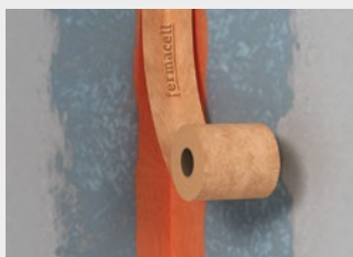
Abb. 2+3: fermacell™ Dichtband in die zuvor aufgetragene, noch feuchte fermacell™ Flüssigfolie drücken und direkt mit Flüssigfolie überstreichen – Trocknungszeit mind. 1 Stunde
