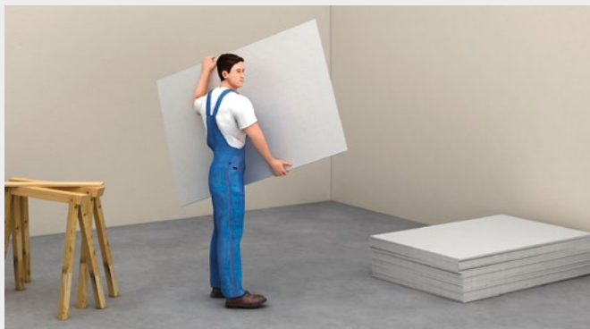
Einzelne fermacell® Gipsfaser-Platten hochkant tragen
