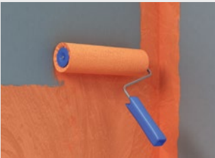
Abb. 6: Sicherstellung der Abdichtung für die Wassereinwirkungsklasse W1-I und W2-I. fermacell™ Flüssigfolie mit der Rolle mind. 2x vollflächig auftragen (Trockenschichtdicke mindestens 0,5 mm). Gemäß DIN 18534-3 wird für den 2. Auftrag ein Farbunterschied zur besseren Nachvollziehbarkeit gefordert. 1. Auftrag: fermacell™ Flüssigfolie in Originalfarbe satt auftragen und trocknen lassen
