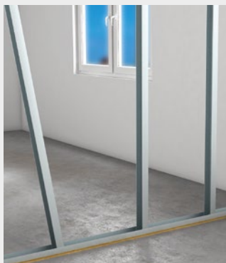
Montage der CW-Ständerprofile
