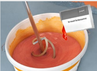
Abb. 7: 2. Auftrag: Farbkonzentrat zur Restmenge der Flüssigfolie geben und homogen einrühren. Eingefärbte Flüssigfolie satt auftragen. Weitere Informationen sind im Produktdatenblatt zu finden. Es ist empfehlenswert, den zweiten Anstrich quer zum Ersten aufzutragen, um evtl. Fehlstellen in der Abdichtungsschicht zu vermeiden.
