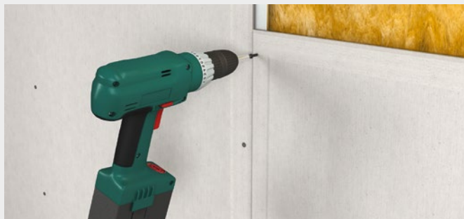
Schrauben auf Stahl-Unterkonstruktion
