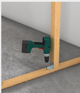
Montage der Holzständer mit Stiftnagel oder Stahlwinkel
