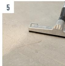
5 Eingebrachtes Harz in noch feuchtem Zustand mit UZIN Perlsand 0.8 absanden, um einen guten Haftverbund zu nachfolgenden Materialien zu erzielen. Nach der Erhärtung losen Sand absaugen.
