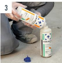
3 Inhalt der Flasche der Komponente A in die Flasche der Komponente B schütten und diese verschließen. Dann 15 Sekunden intensiv anmischen. Die Konsistenz kann je nach Wartezeit von dünn (2 Minuten) bis pastös (6 Minuten) frei gewählt werden.
