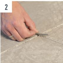
2 Lose Flankenteile des Estrichs entfernen. Fugen und Risse sorgfältig aussaugen. Die beige-packten Wellenverbinder in die Querschlitz einlegen.
