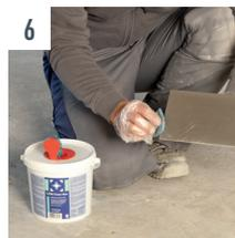
6 Innerhalb von 30 Minuten ist der Riss kraftschlüssig verschlossen. Die Oberbelagsarbeiten können fortgesetzt werden. Werkzeuge sofort nach Gebrauch mit den Reinigungstüchern der UZIN Clean-Box reinigen.
