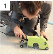
1 Risse zunächst so erweitern, dass UZIN KR 516 leicht eingegossen werden kann. Bei Rissen, die durch die gesamte Dicke des Estrichs gehen, in Abständen von ca. 25 cm mit einem Winkelschleifer (z.B. WOLFF Estrichfugenschneider EF 135) Querschlitz bis 2/3 der Estrichtiefe einschneiden.
