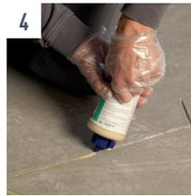
4 Den Riss mit der Mischung satt füllen. Überschüssiges Harz entlang der Risse, bzw. Fugen mit der Spachtel auf schmaler Breite abziehen.
