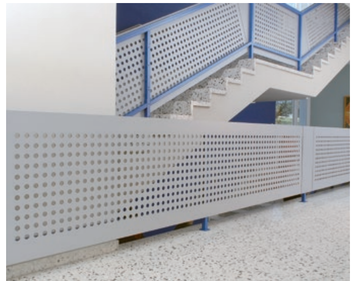
STIEGEGELÄNDER - LOCHFRÄSUNGEN
