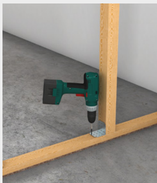
Montage der Holzständer mit Stichtagel oder Stahlwinkel
