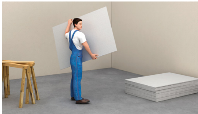
Einzelne fermacell® Gipsfaserplatten hochkant tragen
