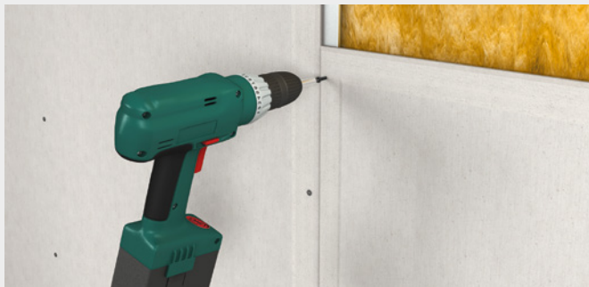
Schrauben auf Stahl-Unterkonstruktion
