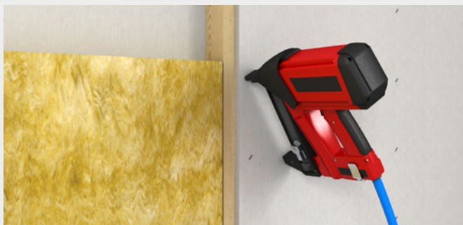
Klammern auf Holz-Unterkonstruktion
