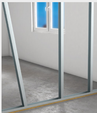
Montage der CW-Ständerprofile
